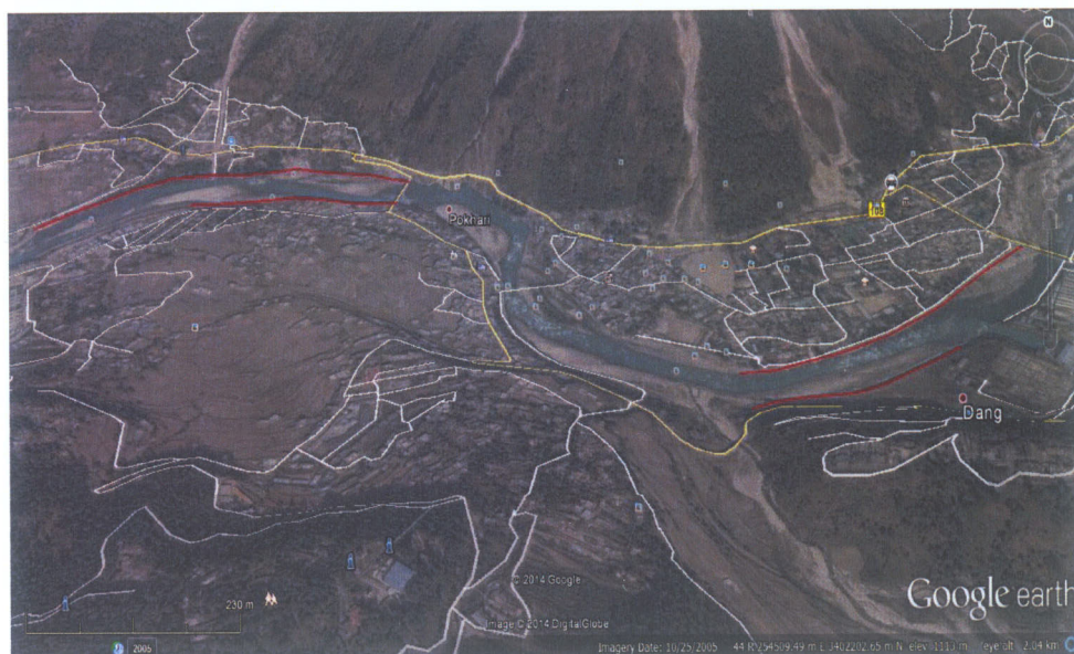
उत्तरकाशी शहर की सैटेलाइट इमेज
